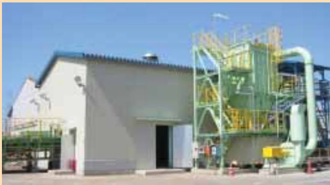
セメント工場内廃木材チップ燃料化設備
