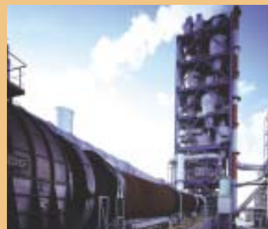
宇部セメント工場のNSPキルン
