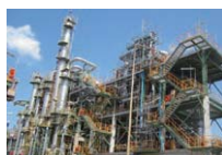
タイ PCD製造設備 (化学カンパニー)
