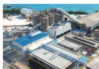
刈田セメント工場 排熱発電設備 (建設資材カンパニー)
