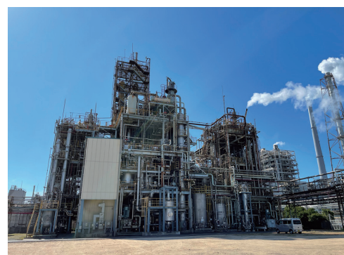
DMC製造工場(山口県宇部市)
