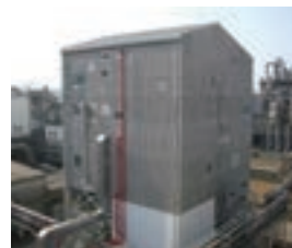
宇部ケミカル工場内の中空糸製造設備(Ⅲ期)
