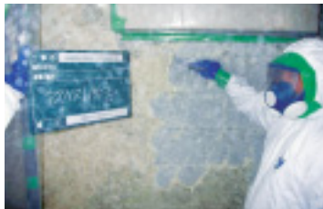
石綿除去工事
