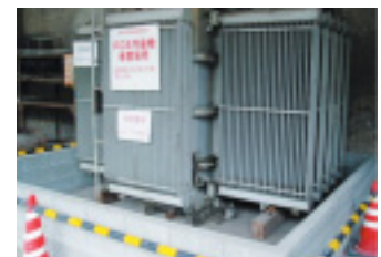
PCB保管場所
