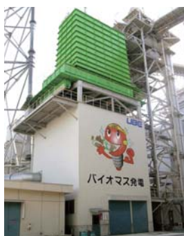
バイオマス燃料化設備
