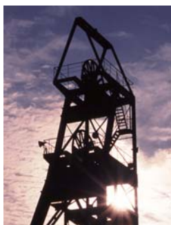
沖ノ山電車堅杭巻き上げ機
