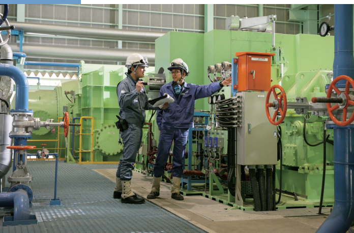
写真左： 排熱発電設備・仮焼炉に新設された「PHボイラ」 写真右： 排熱発電設備・タービン、発電機などを格納「タービン建屋」
