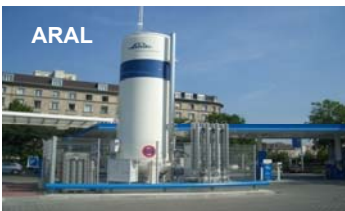
CEPベルリン。セルフ充填液体水素貯蔵式と水電解式
