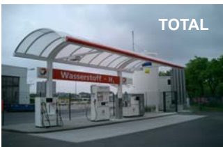
H-CUTEベルリン。セルフ充填液体水素貯蔵とLPG改質
